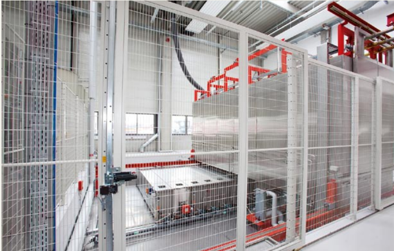
▲ Sprühtunnel (rechts) mit Blick auf die Behälter für die Aktivbäder (unten)
